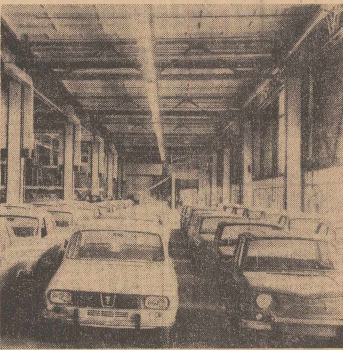
În cîntecul zilei de 23 August, constructorii de la I.C.M. 5-Pitești au înzestrat Uzina de autoturisme cu noi și importante secții productive. Este vorba de secția de segmente, a cărei producție, va fi destinată altor nevoilor uzinei piteștene, cit și exportului, și de patru hale destinate etapei a II-a de integrare a autoturismului Dacia-1300. În clișeu: O imagine din hala de finisaj a Uzinei de autoturisme
