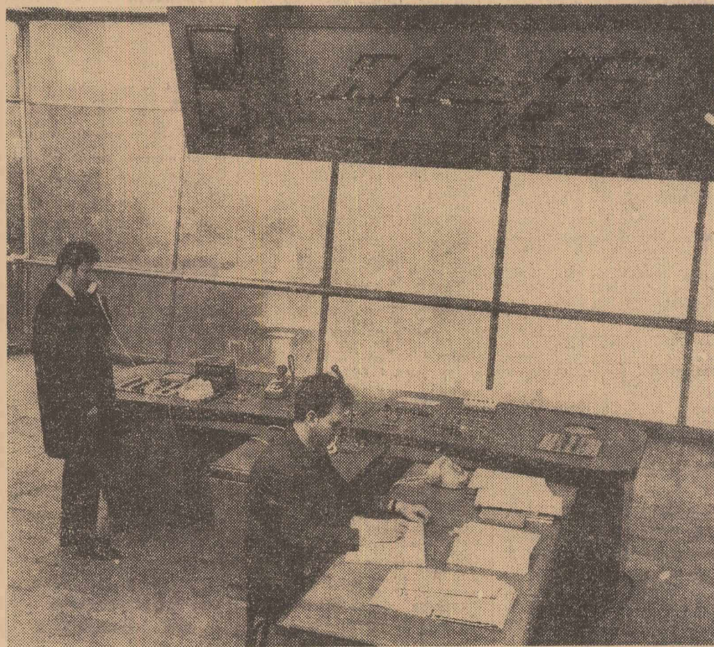
Laminorul de tablă groasă de la Combinatul siderurgic Galați, primul obiectiv intrat în funcțiune pe platforma Smîrdanului. Imaginea este luată din cabina dispecerului. În precima lingurilor incandescente ce trec prin cale, specialiștii au în permanență, prin intermediul mijloacelor complet automatizate, viziunea întregului flux tehnologic. Ecrane de televiziune industrială, schema sinoptică a întregului ciclu de fabricație, permit controlul și coordonarea de la distanță a regimului tehnologic.
