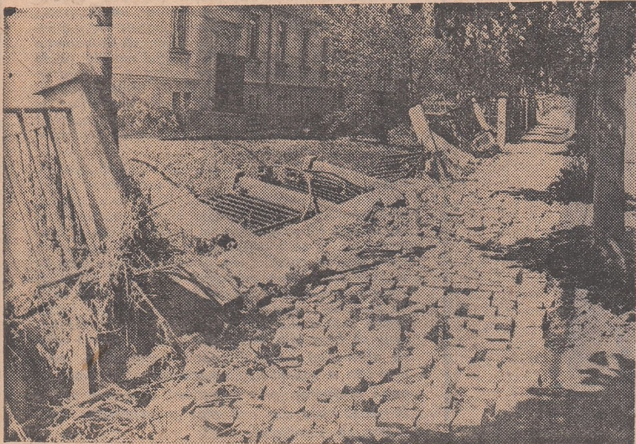
Stradă din Reghin după inundații
