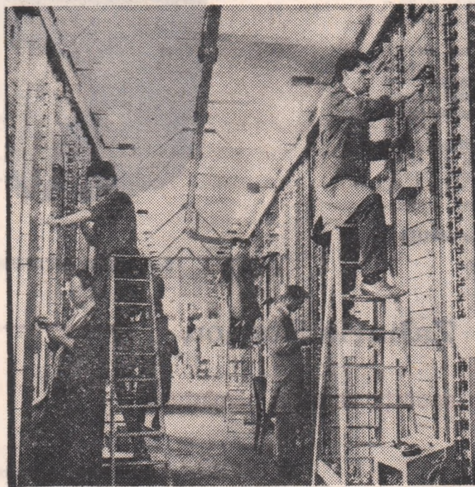
Electromagnetica. Aspect de la linia de centrale telefonice automate de 10.000 linii
