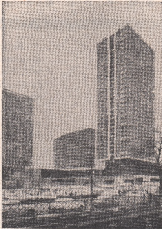
Primele turnuri pe șantierul operației Beagrennelle.
