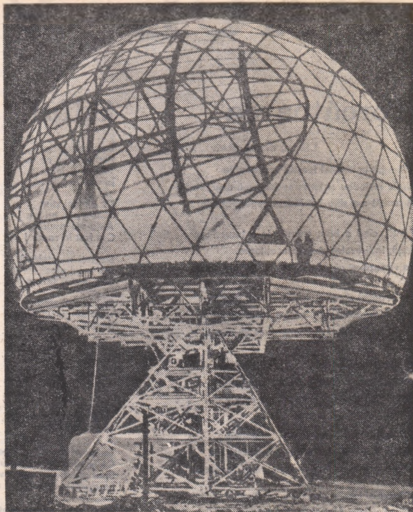
Stalație modernă de radar
