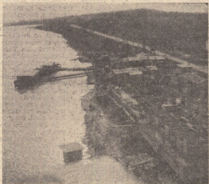
Stația de pompare a sistemului de irigații Pietroiu — Stefan cel Mare
