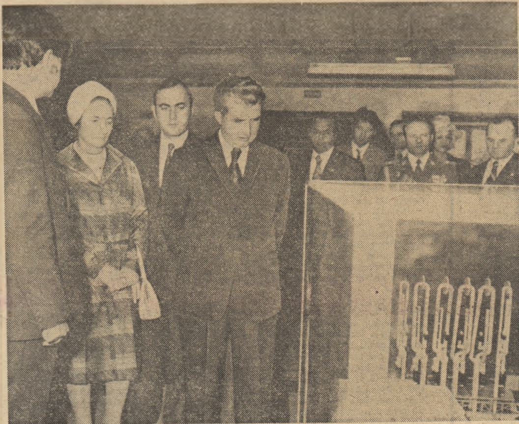
IRAN, sîmbătă 29 noiembrie 1975: tovarășul Nicolae Ceaușescu și tovarășa Elena Ceaușescu, vizitînd centrul de control și comandă al modernelor instalații de la Kharg
