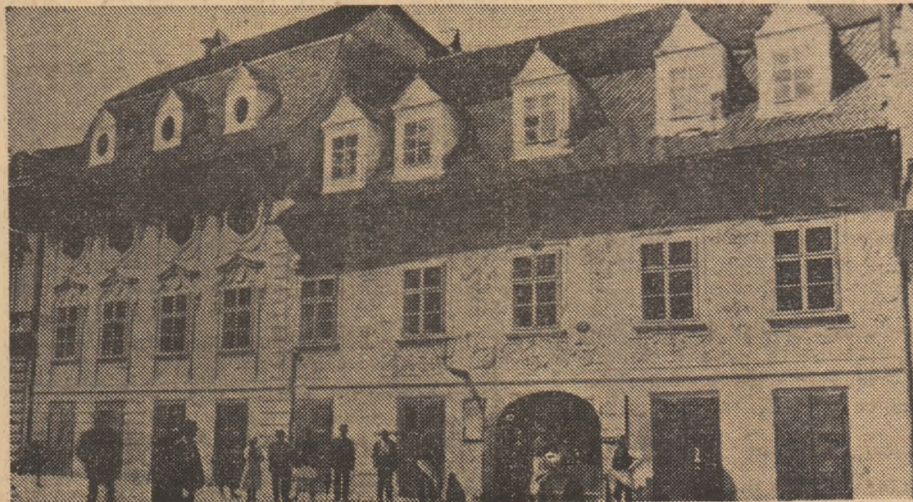
Fațada vechii clădiri a Teatrului din Brașov, numit și „Reduta”, în care a jucat Millo la 1870
