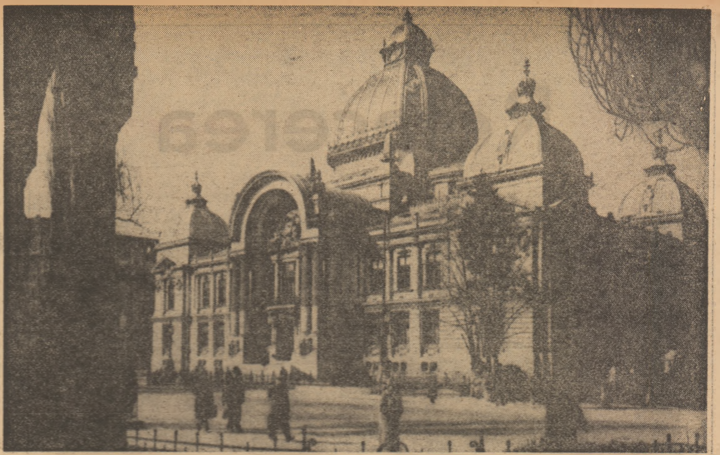
Edificiul Casei de economii și consemnațiuni din București
