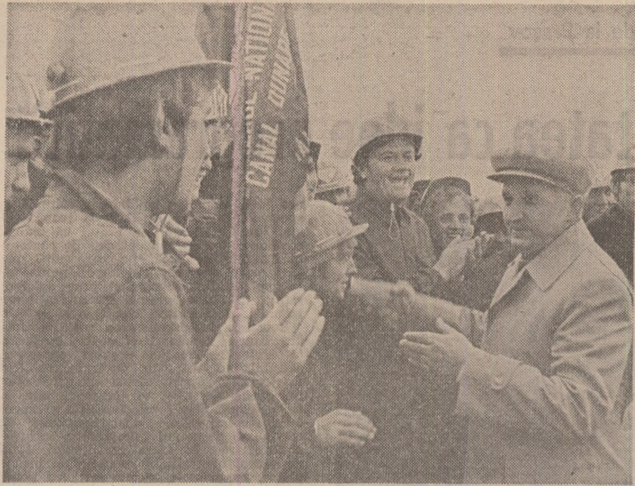
27 V 1977. În mijlocul constructorilor de pe Șantierul Național al Canalului Dunărea - Marea Neagră
