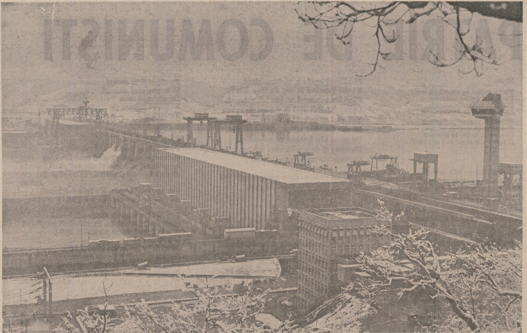
Hidrocentrala de la Porțile de Fier
