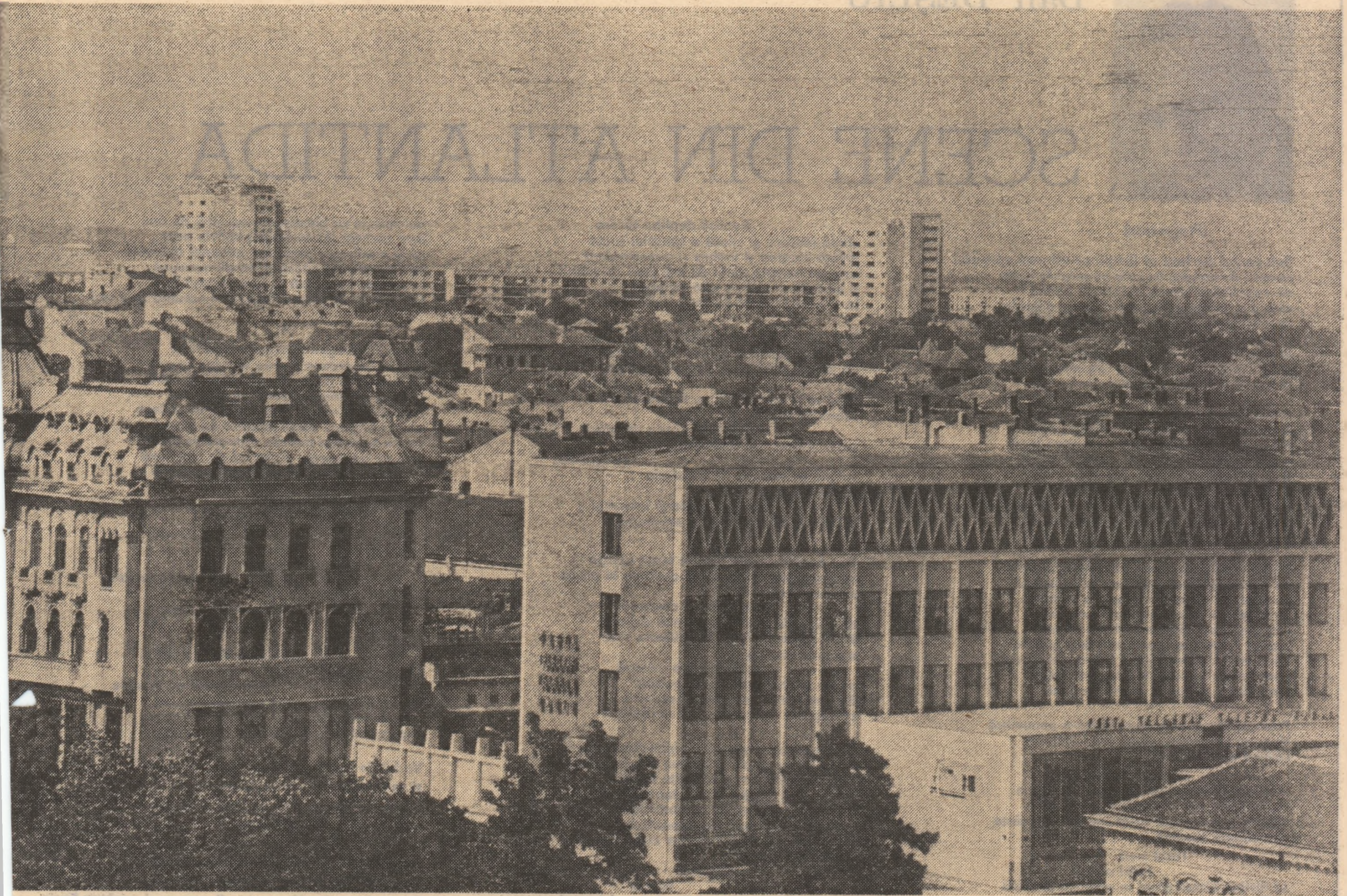
Construcții noi la Drobeta-Turnu Severin
