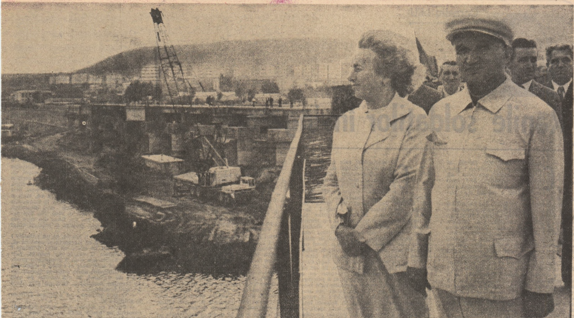
Pe șantierul Canalului Dunăre — Marea Neagră
