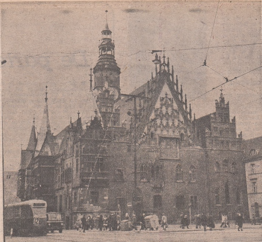
Clădirea primăriei din Wroclaw
