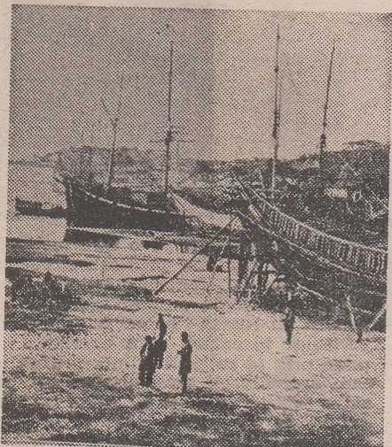
Șantier naval la Giurgiu, în 1867, Fotografie de Carol Popp de Szathmari aflată în colecțiile Bibliotecii Academiei Române
