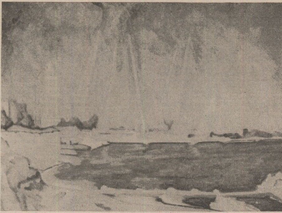
VIRGIL MIŞU : Şantier portuar Agigea (Bienala de pictură şi sculptură)
