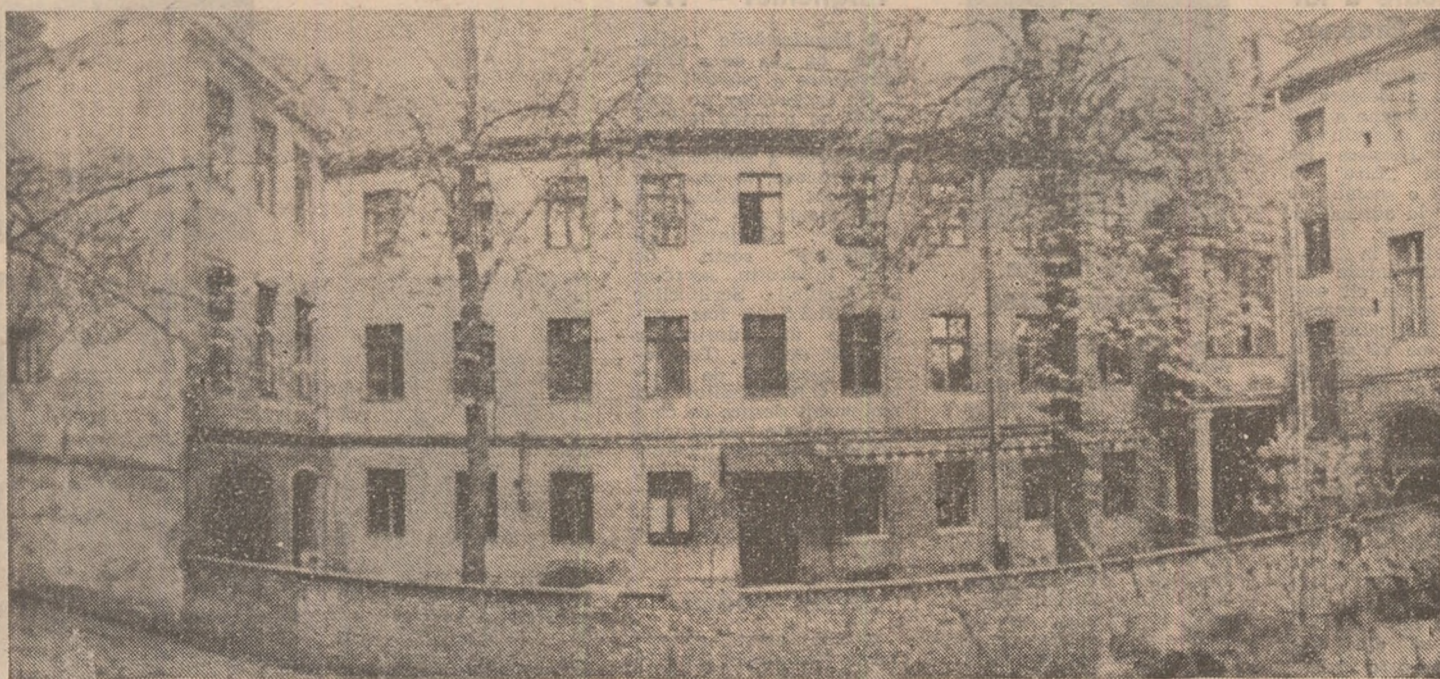
Casa din Chaussestrasse
