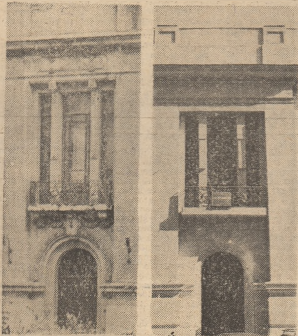
Traveea intrării principale spre str. Dr. Sion înainte (1986) și după (1989) terminarea lucrărilor. Dispariția profilaturii, detaliată în proiect la sc. 1/1 și a tuturor ornamentelor exterioare a transformat restaurarea într-o reparație primitivă
