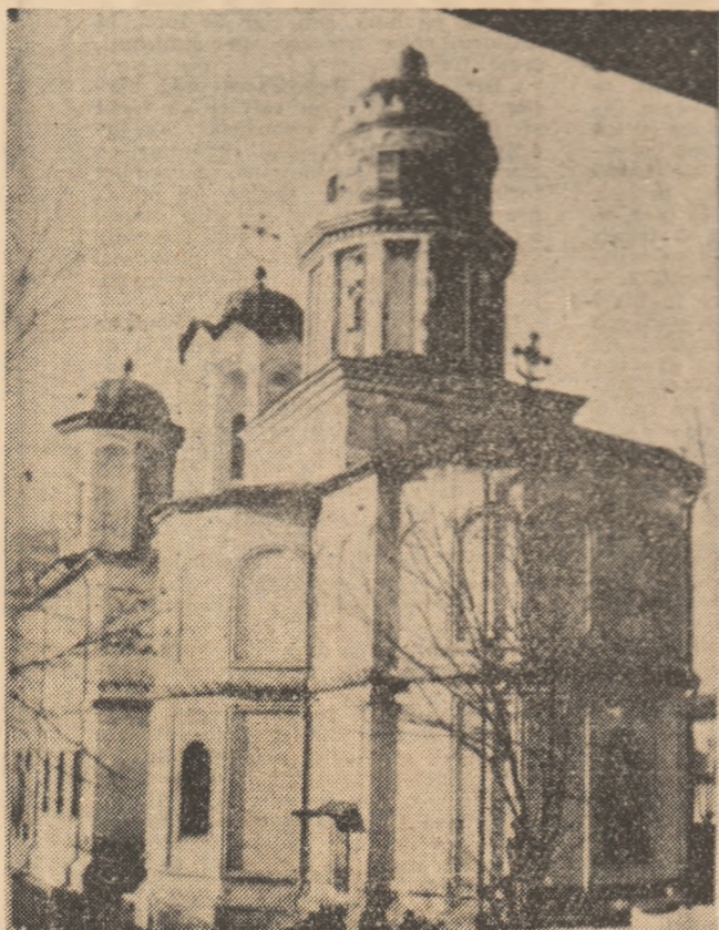
Fațada de est
