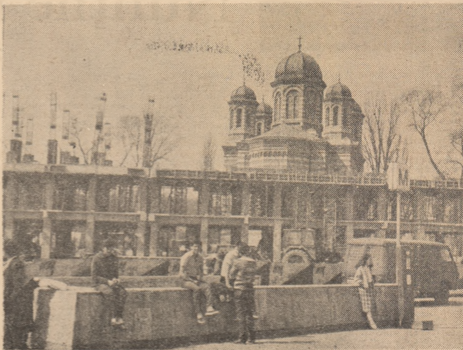
Biserica Domnița Bălașa în timpul lucrărilor de „încercuire și ascundere” (1985)
