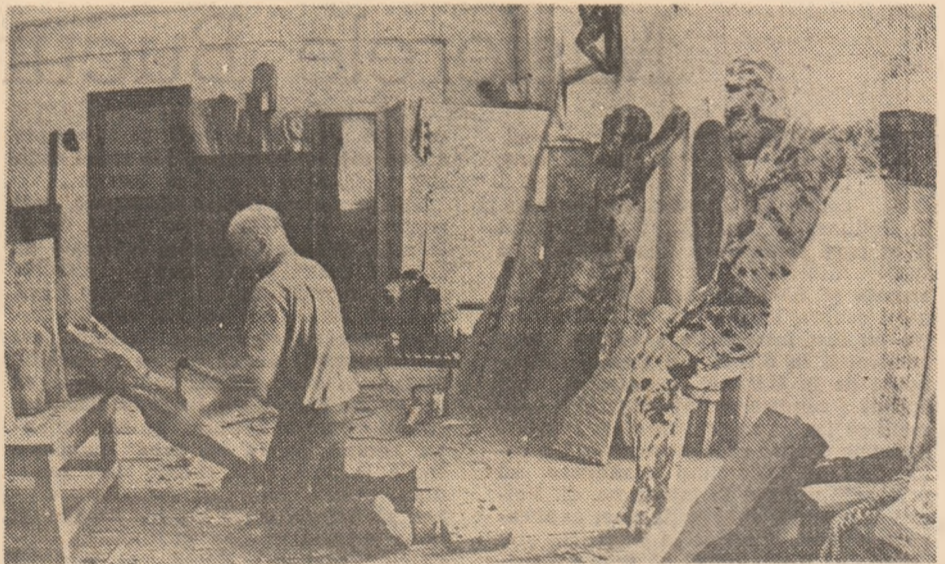
În atelierul din strada Bateriilor, astăzi demolat
