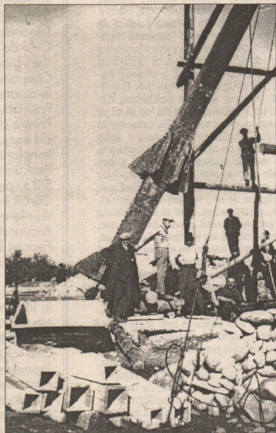
Fotografie realizată în timpul instalării Coloanei
