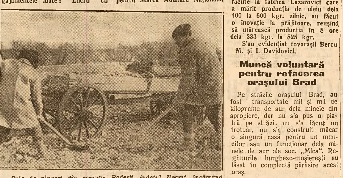
Sute de plugari din comuna Bodești, județul Neamț, încercând prudenț pentru repararea șoselei din comună.
