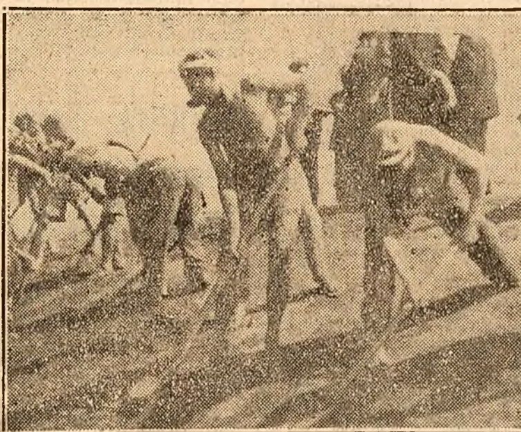
„Câteva clipe” încă și în sectorul grupei noastre digul a gata! Pe șantierul național „Ana Pauker” — Lunca Prutului, tinerii din brigada IV Brăila, se grăbesc să termine lucrările sectorului de dig dela punctul „Vadul lui Isac”. Ei vor să treacă fără întârziere în altă parte a șantierului căci marea întrecere începută la 1 Iunie între cele trei șantiere naționale nu privește sectoare de șantier ci șantierul întreg.
