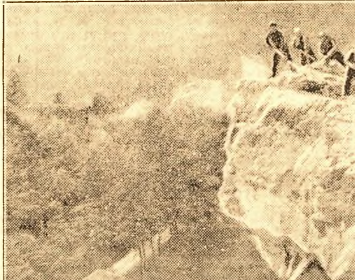
Asa se lucrează la terasamentele dela „Trecerea prin stâncă”. Și pe aici, pe marginea râpei abrupte de unde Jiul se vede ca o suviță alburie, pe aici, va trece trenul. Înainte de termen!
