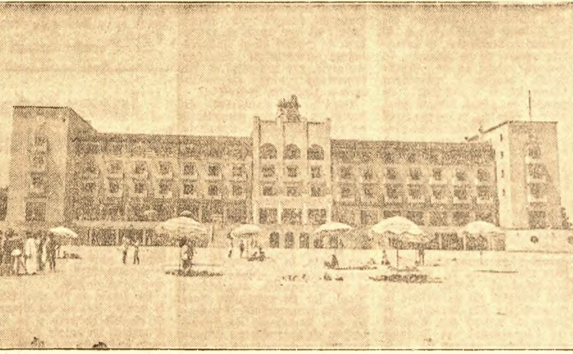
Iată, hotelul „Rex” dela Mamaia. In această clădire, înzestrată cu cel mai modern confort, își cheiltau exploatarea înainte de a fi concediați de odihnă luptătorii de frunte pentru îndeplinirea și depășirea Planului de Stat, muncitori decorați cu „Ordinul Muncii” și „Medalia Muncii”.
