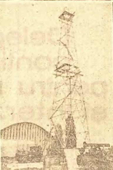
O sondă metalică de 45 metri înălțime, cu utilajul respectiv, a fost înălțată lângă hala Expoziției Industriei Sovietice. Astfel de sonde puternice, pentru mare adâncime, se găsesc cu mii în schemele bogatelor regiuni petrolifere din U.R.S.S.
