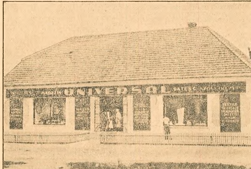
De curînd în comuna Bory, raionul Aleșd, s-a deschis un magazin universal unde țărani muncitori se aprovizionează cu unelte agricole, articole textile, confecții, articole de uz casnic etc.
