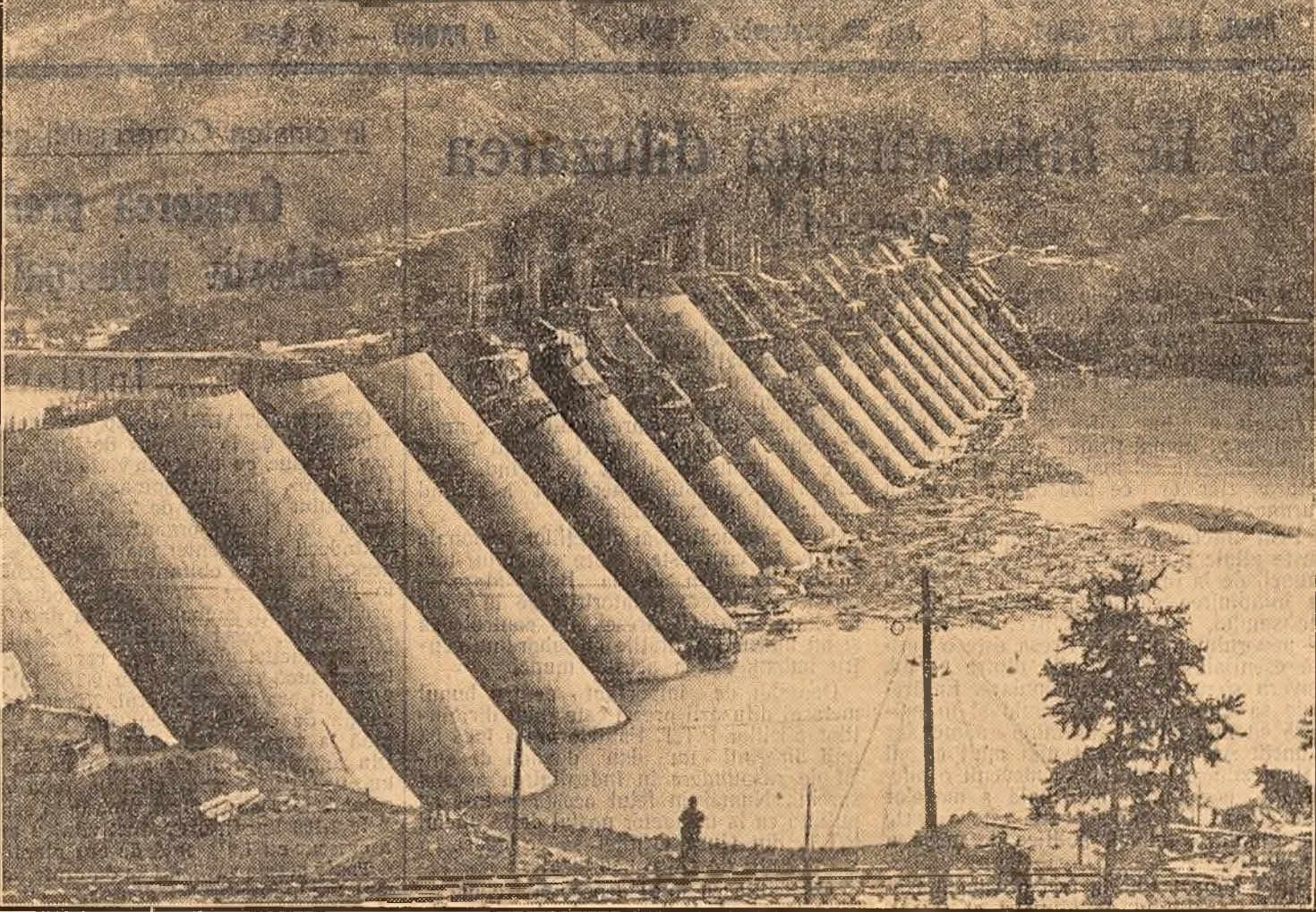
În R. P. Chineză se desfășoară în prezent uriașe lucrări pentru folosirea rațională a apelor. În clișeu: Un aspect al barajului de la Fo Zi Lin, construit pe cursul superior al unui afluent al marelui fluviu Huai.
