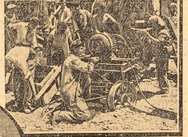
Sus: La fabrica automată de beton echipa brigadierului Adam toarnă betonul în bunkerul central.
