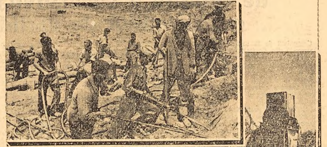
Sus: Brigadierii lui Ion Pușcas au ieșit la muncă. Perforatoarele găresc piatra, ca să facă loc dinamitei. Aici se vor turna în curînd fundațiile.
