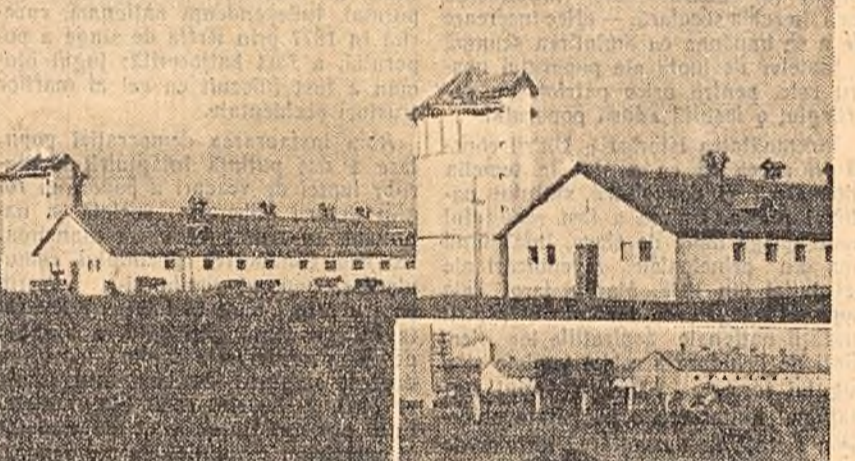
La gospodăria agricolă de stat „7 Noiembrie” Cobadin, raionul Negru Vodă, au fost construite în ultimii ani, 6 grajduri de vite, prevezute cu instalații de adăpare automată.
