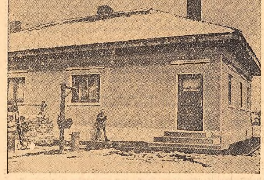
Iată casa pe care și-a înălțat-o în Dămăroaia, cu ajutorul statului, strungarul Pantelimon Popov de la „Grivița Roșie”.
