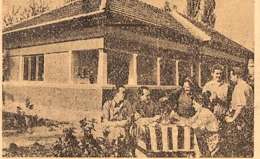
Printre numeroșii muncitori de la stațiunile de mașini și tractoare care și-au construit case cu ajutorul împrumuturilor primite din partea statului se numără și mecanicul Alexe Bogdan de la S.M.T.-Bărcănești. Noua sa casă se compune din trei încăperi, baie, bucatărie.
