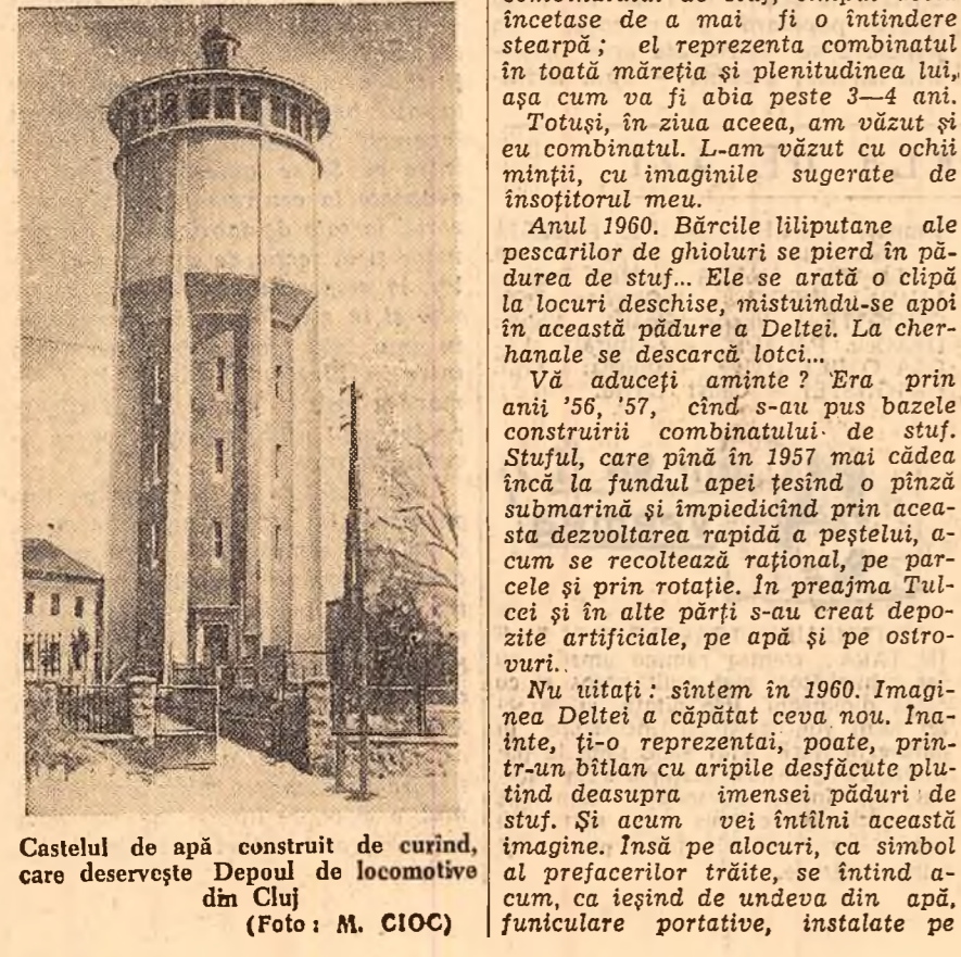
Castelul de apă construit de curînd, care deserveste Depoul de locomotive din Cluj (Foto: M. CIOC)
