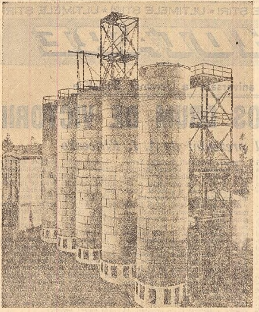
La Combinatul Chimic nr. 1 se construiește o fabrică de acid azotic. În clișeu primele 5 turnuri de absorbție.
