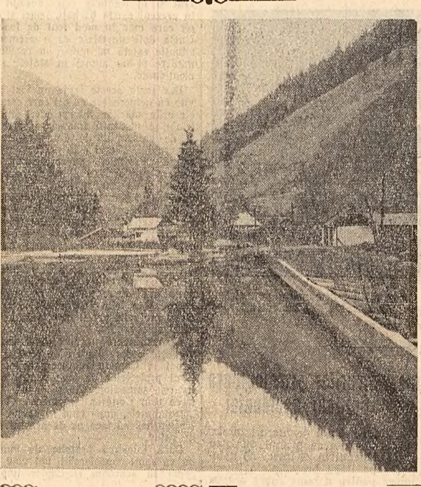
Pe apele repezi din munții Sucevei se practică plutașul dijevat. În acest scop au fost amenajate numeroase lacuri de acumulare a apei cu ajutorul cărora se transportă în fiecare an zeci de mii de metri cubi material lemnos.
