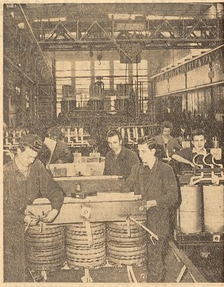
Colectivul sectorului transformatori de la uzina „Electroputere”. Craiova s-a angajat ca în cinstea zilei de 1 Mai să execute peste plan, printre altele, montarea bobinelor unui nod de transformatori. Iată-i în fotografia noastră pe montatorii frunțași Florea Popa și Marin Spiridon (în prim plan) în timpul lucrului. (Foto Gh. Vințilă)
