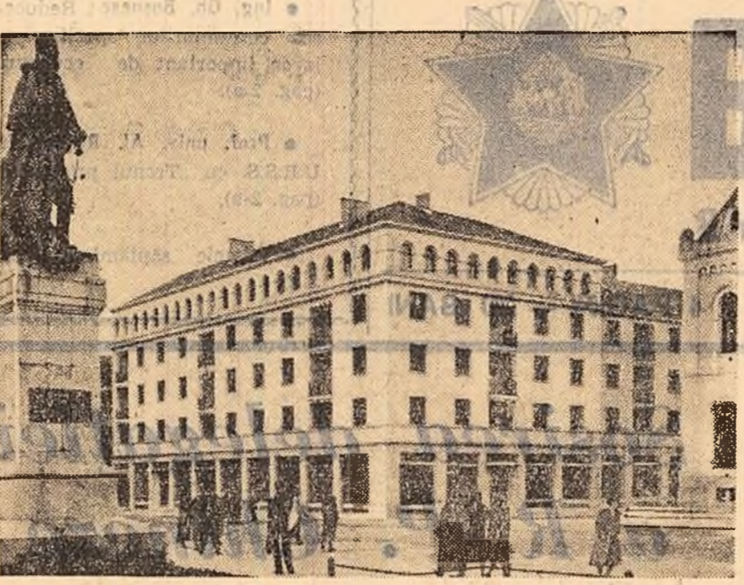
Numeroasele locuințe construite în ultimii ani în orașul Craiova li s-a adăugat, de curînd, încă un bloc cu aproape 100 de apartamente, dintre care o parte au și fost date în folosința oamenilor muncii. În fotografie: Aspect exterior al noului bloc. (Foto Gh. Vintîlă)
