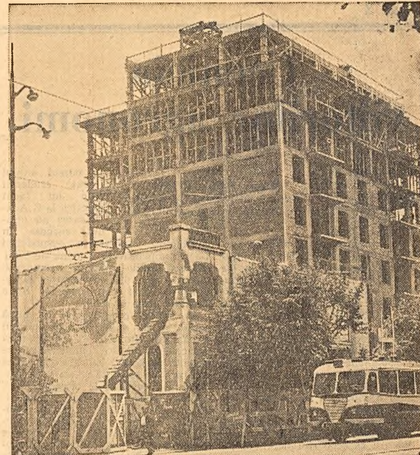
Pe bulevardul Magheru. Încă pușîn și bătrîna clădire va ceda sub loviturile tirînoapeilor, cedînd locul unor noi și moderne blocuri de locuințe. (Foto R. Costin)
