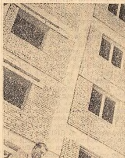
Construcția corpului A al blocului 2 pe strada Doamnei nr. 23-29 din Capitală se apropie de sfîrșit. În fotografie: pregătirea planului de finisare exterioră.
