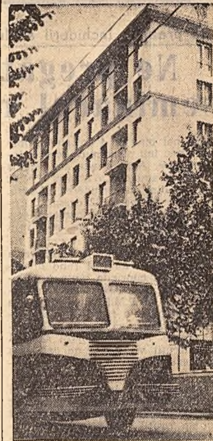
Pe bulevardul 6 Martie din Capitală este aproape finisat un bloc cu șapte etaje avînd 52 de apartamente.
