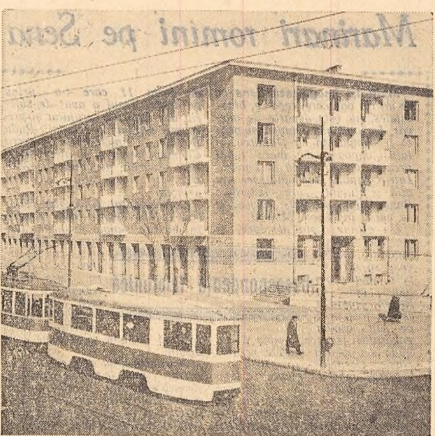
Noul bloc de locuințe de pe Calea Griviței nr. 286 din Capitală. Aici s-au mutat nu de mult 75 de familii de muncitori de la Atelierele C.F.R. „Grivița Roșie”. (Foto: M. Cioc)
