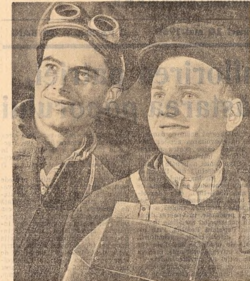
Sudorii Mihai Lupu și Aurel Apostol sint apreciați de întregul colectiv al uzinelor de superfosfați Năvodari. Ei execută lucrări de reparații, uneori la temperaturi înalte. De curînd, datorită executării rapide a reparațiilor făcute de ei la cuptoarele de prăjit pilită, s-au putut produce în plus 100 tone de superfosfați. (Foto: Gh. Vințilă)
