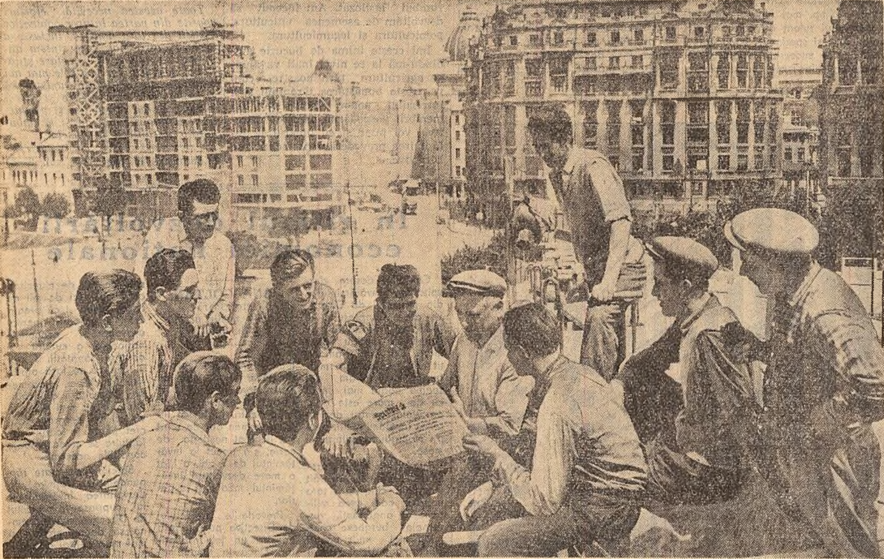
A sosit ziarul și prînzul cel ce lucrează la înălțime. Ne aflăm pe unul din numeroasele șantiere de locuințe ale Capitalei — blocul turm de 17 etaje care se înalță în Piața Splaiului. În pauza de prînz, brigădiarii s-au adunat în jurul mesei lui Nistor Munteanu. Iată-l citînd capitolul din proiectul de Directive privind la „Investiții-construcții”.
