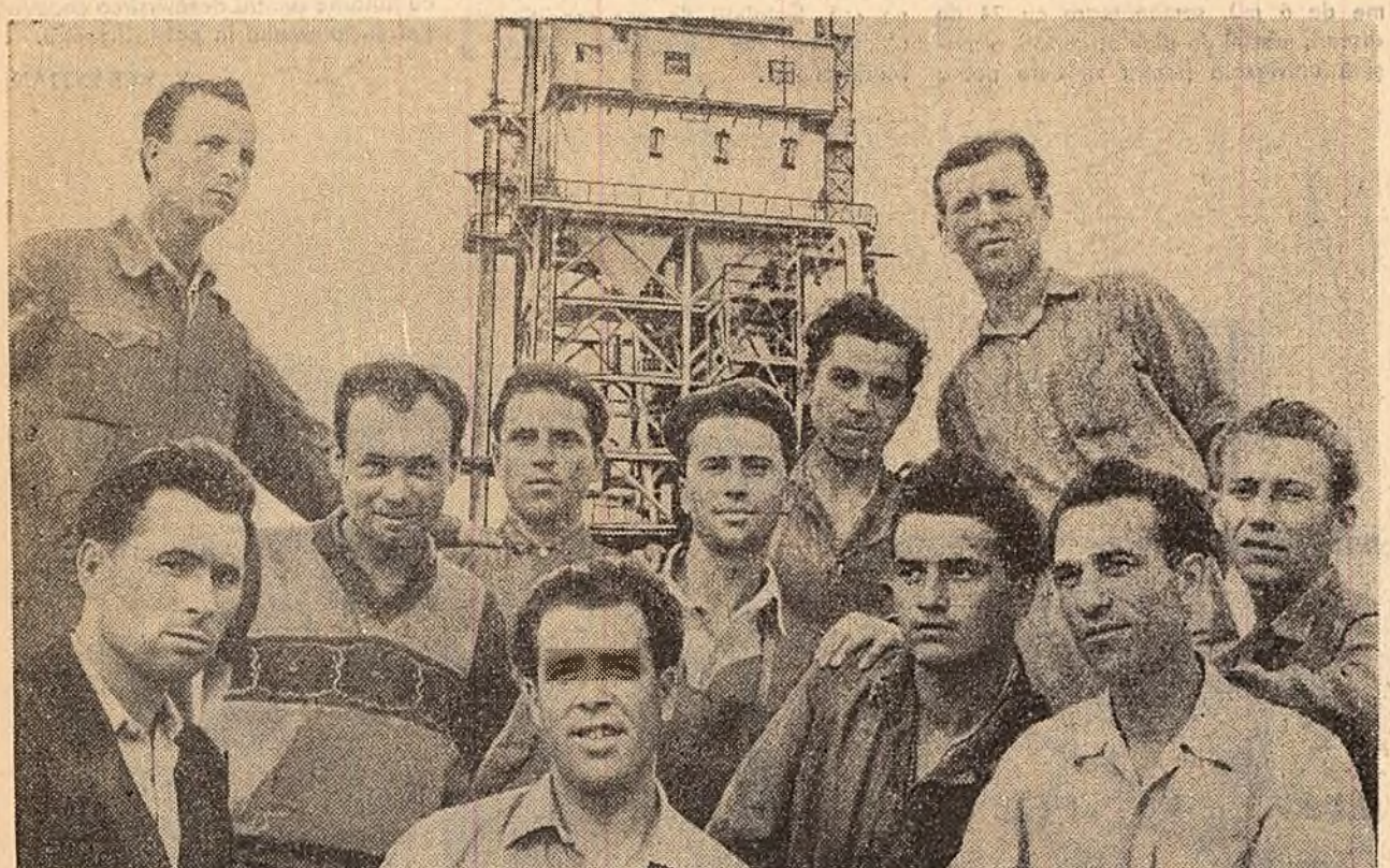
Instalatorii din brigada condusă de comunistul Gheorghie Cotej lucrează pe șantierele complexului petrochimic de la Borzești. În primele 5 luni ale acestui an, prin reducerea consumului planificat de materiale cu 2,85 la sută, ei au obținut economii în valoare de 58.122 lei, executînd în același timp lucrări de bună calitate — rezultate pentru care li s-a decernat steagul de brigadă fruntaș pe șantier. În această lună ei au adăugat succesorilor de pînă acum noi realizări obținute în întrecere,
