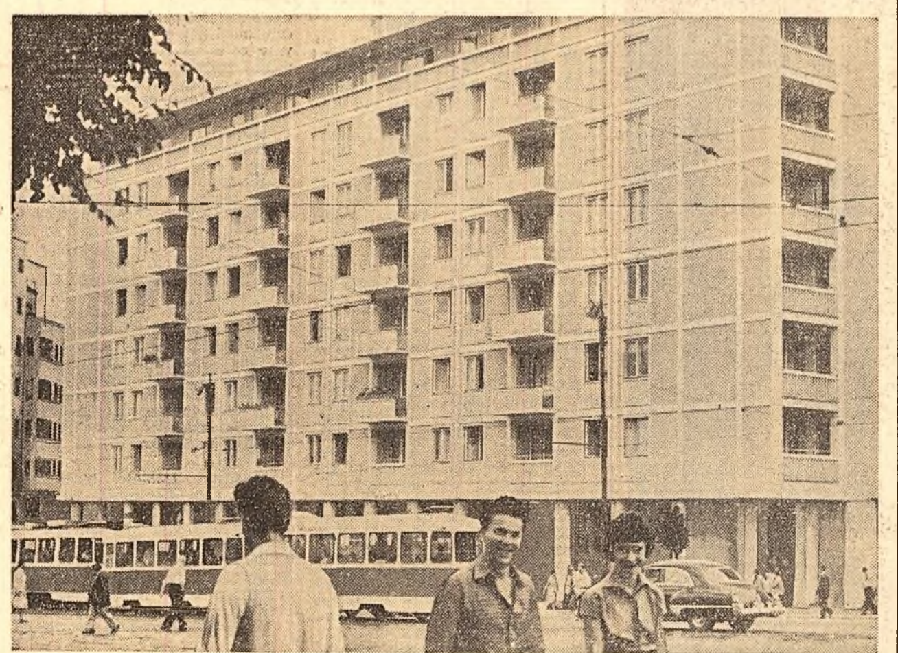
Noul bloc cu 7 etaje și 88 apartamente din Capitală, b-dul 1848, colț cu str. Gabroveni, dat de curînd în folosință.
