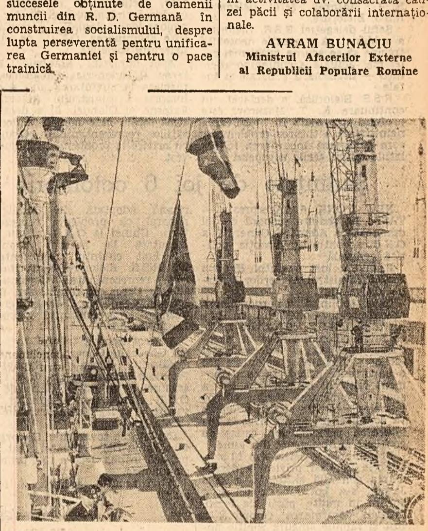
După 30 de luni, într-un timp record în practica mondială, au fost încheiate lucrările de construcție a primului sector al noului port oceanic Rostock. În fotografie: Chelurile și macaralele de 3,2 tone.
