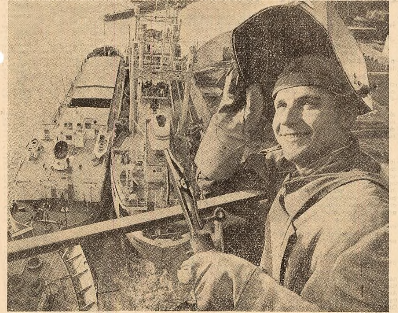
Șantierul Naval Galați. Vechilor ateliere de reparații le-au luat locul hale moderne, unde se construiesc vase felurite. Colectivul șantierelor a obținut anul acesta economii la prețul de cost în valoare de aproape 4 milioane lei. În fotografia pe sudorul Ion Vasiliu, unul din fruntașii în producție al șantierului. (Foto Gh. Vințilă)
