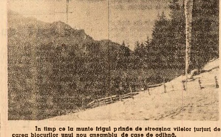
În timp ce la munte frigul prinde de streșina vilelor țurțuri de gheață, pe malul mării, la Mamaia, constructorii muncesc de zor la ridicarea blocurilor unui nou ansamblu de case de odihnă.
