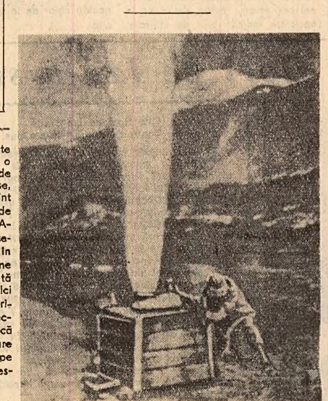
Aburul fierbinte este aruncat la o înălțime de zeci de metri și, răcindu-se, cade pe pământ sub formă de ploaie fierbinte. Această fîntină arteziană se află în Kamelotka, regiune extrem de bogată în ape termale. Aici se construiesc prima centrală electrică geotermică din U.R.S.S. care va funcționa pe baza folosirii acestor ape termale.
