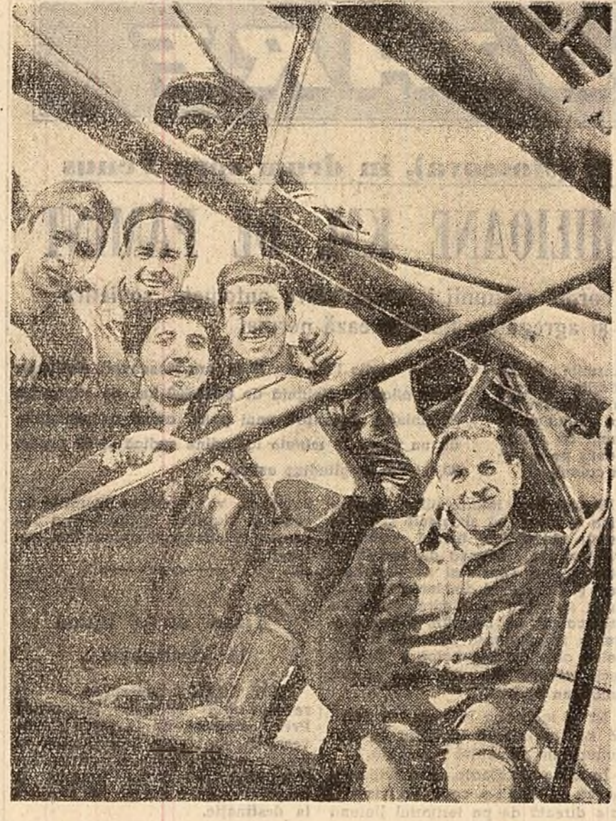
Sectia constructii metalice grele a uzinei de utilaj chimic si petroler nr. 2 din Ploiesti a obtinut anul acesta bune rezultate in productie. In fotografie: echipa compusa din Sorban Manea, Dumitru Nițu, Ilie Popescu, Stan Virgil si Petre Georgea a realizat de la inceputul acestui an economii in valoare de circa 30.000 lei.
